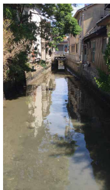
土井の上の井樋
